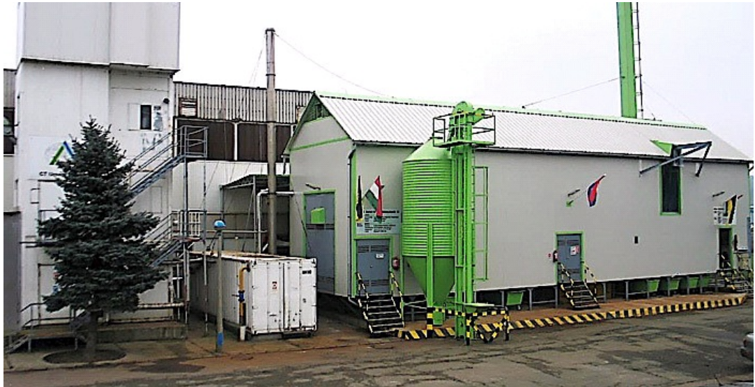
Pilotanlage in Eger, Ungarn (Quelle: Biomov, Eger)
